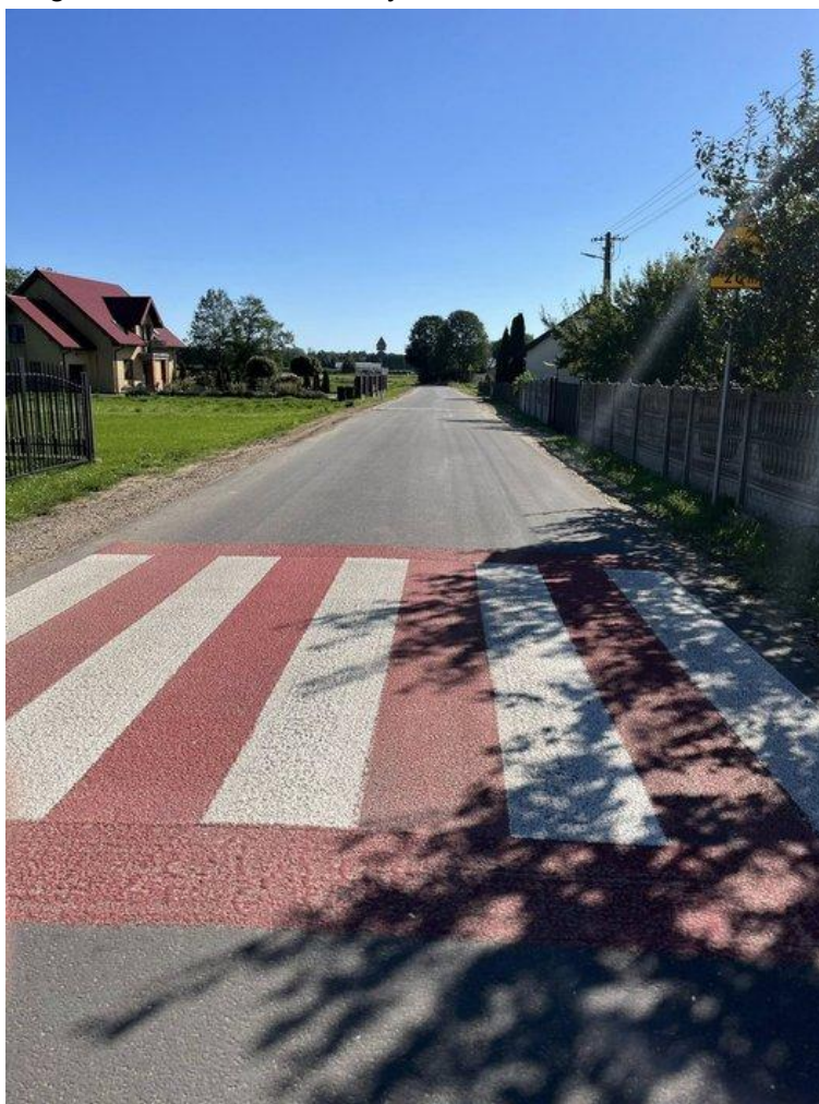
Przebudowa drogi w Woli Pienickiej (2025)
