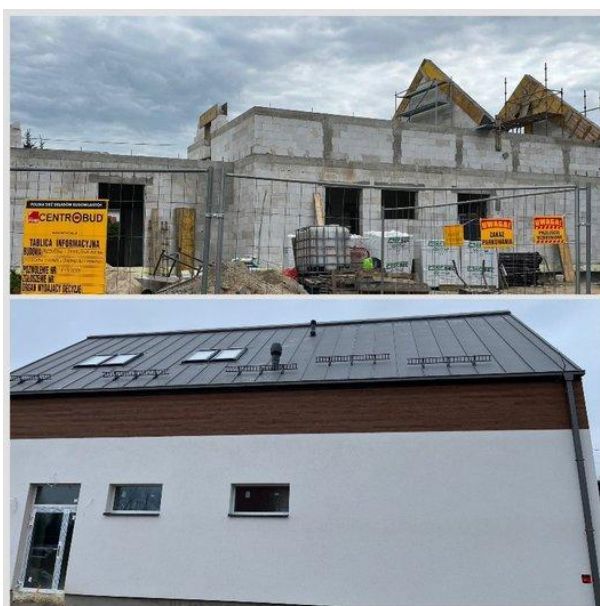
Budowa żłobka w Krasnosielcu (2025)
